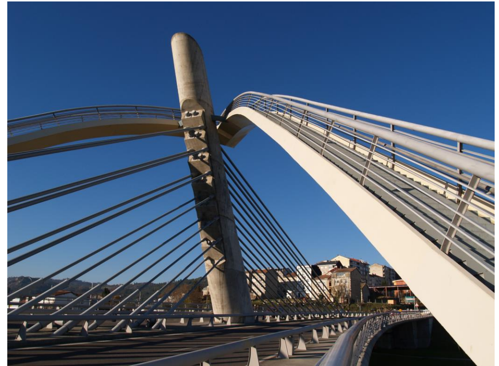
Ponte do Milenio. Ourense.
