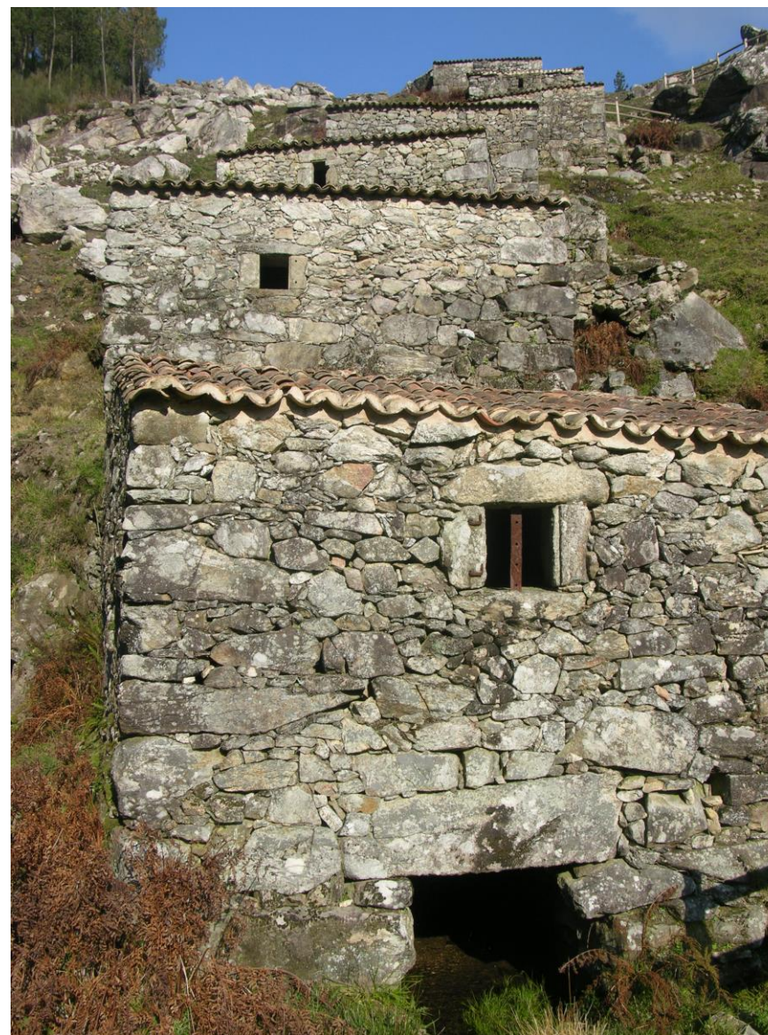
Muíños do Folón (O Rosal). Un conxunto de 36 muíños encadeados de xeito que a auga que sae de un é aproveitada polo seguinte.
