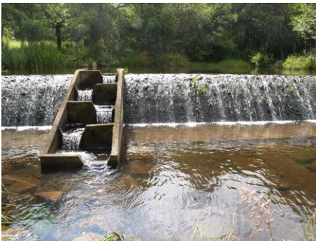
Escada para os peixes nunha minicentral do río Ourille, afluente do Arnoia
